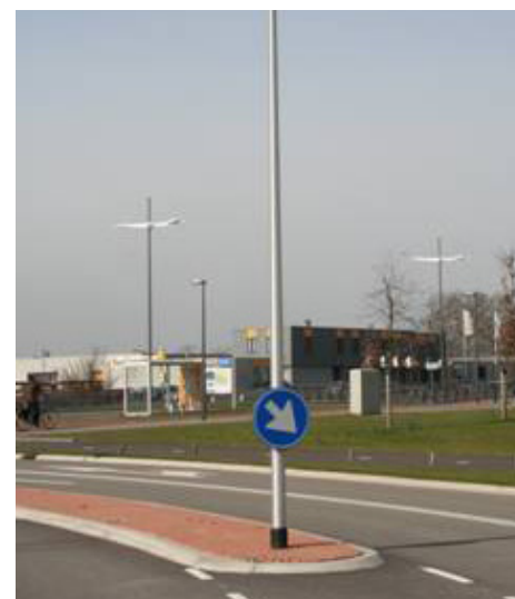
Mast: Stalen conische mast met uithouder (bij voorkeur poedercoaten in een lichtgrijze RALkleur)
