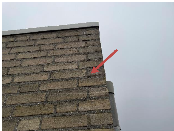
Beschadiging van het mw door weersinvloeden
