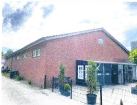
Hal laag buitenzijde
