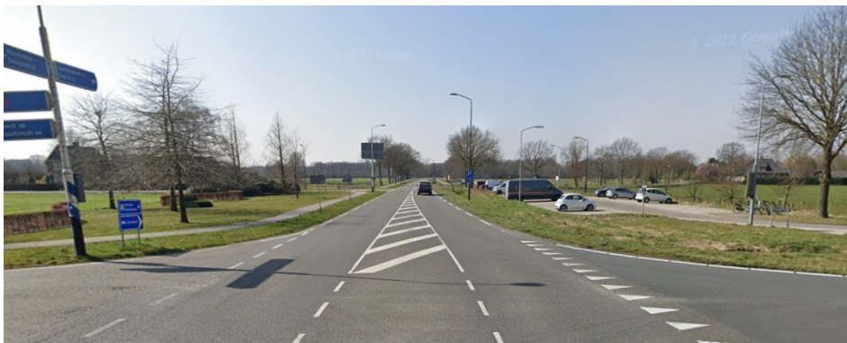
Afb. 10 Fietsoversteek over ETW aan einde verdrijvingsvlak
