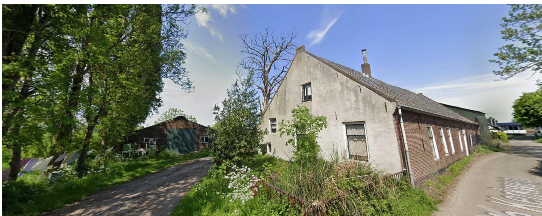
Impressie noordelijk perceel plangebied, zicht op woonhuis en agrarische bebouwing (bron: Google Street View).
