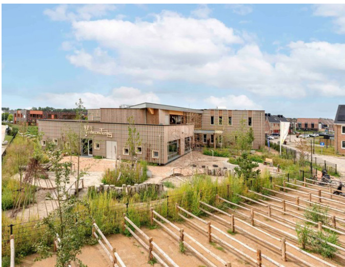
Groene schoolpleinen en toegankelijk buiten schooltijden
