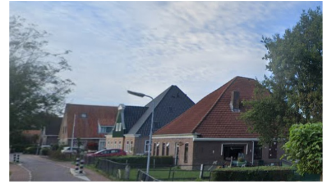
stolpstructuur herkenbaar in lint
