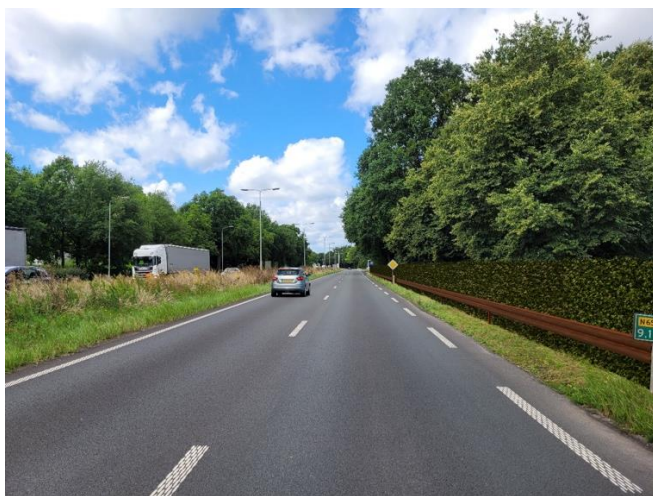
Geluidscherm 2 m hoog + vangrail (Helvoirt: locatie - N65 zijde)
