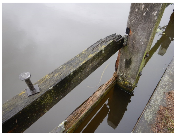
Figuur 4.15: Doorgerotte en aangetaste gording X374
