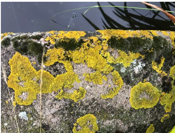
Figuur 4.1: Aangroei op doorlaatkoker 412
