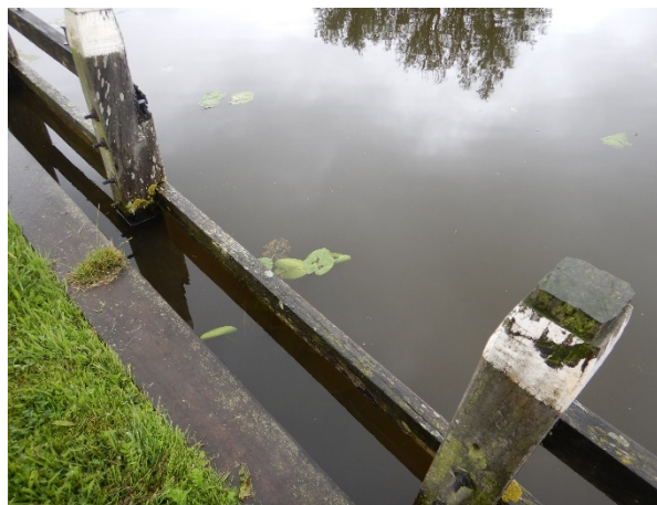
Figuur 4.13: Ontbrekend deel gording
