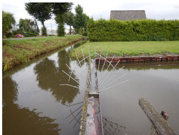
Figuur 4.25: Vervuiling en spijl hek zit los
