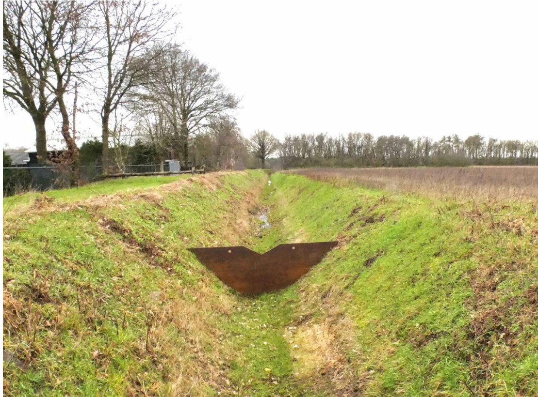
Bovenloop van de Palmenloop, die het water van het Palmven moet afvoeren 19-2-2023
