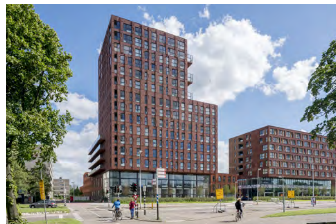
Woontoren De Verkenner, Utrecht
