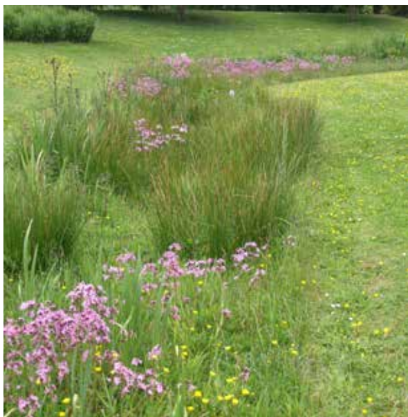
afkoppelen en infiltreren hemelwater (wadi)
