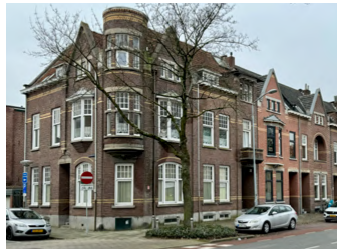
Tip 2c. Kunststof gevelelementen detoneren in een historische gevel en missen de oorspronkelijke verfijning.
