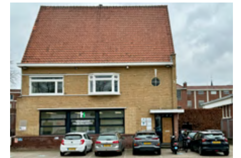
Werk aan de winkel: kantoorpui en parkeren in de voortuin.
