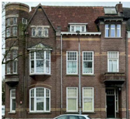
Overgangsarchitectuur in een mix van historisme en rationalisme.
