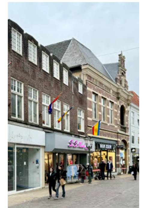
De begane grond is losgesneden van de prachtige verdiepingen in de Lomstraat.
