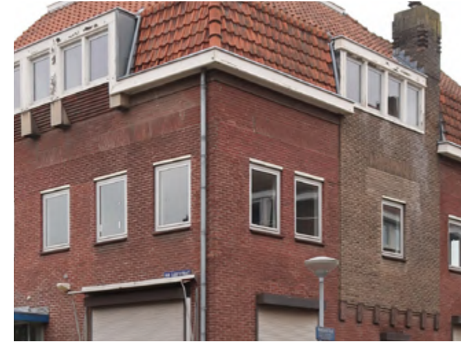
Tip 2d. Herstel bijzondere details en ornamenten want die geven karakter aan de gevel.
