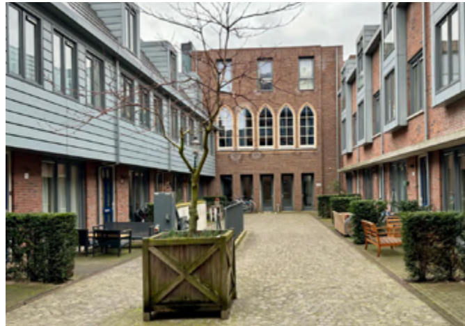
Achter het Ald Weishoes is de binnenhof verdicht met een kleinschalig woningbouwcomplex aan het Knibbelstraatje: rustig wonen in de luwte van de drukke binnenstad. De achterkant is een voorkant geworden.
