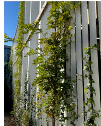
Spankabels aan gevel voor klimplanten.
