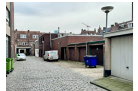
Werk aan de winkel: onaantrekkelijke en stenige achterkanten op de binnenterreinen.
