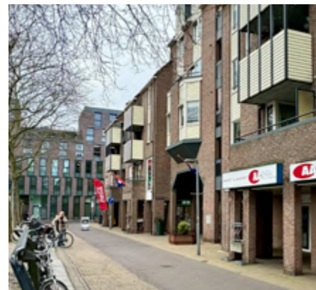
De kleinschalige architectuur van de stadsvernieuwing.
