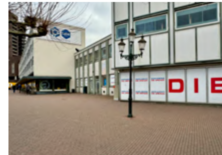
Harde ontmoeting vloer en plint.
