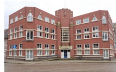
Voorbeeldig geslaagde herbestemmingen: voormalig politiebureau tot woningen.
