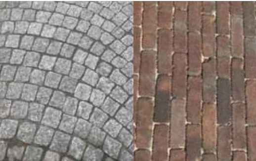
Hoofdentree gebouw A Kinderkoppen in waaiervorm met aan weerszijde een bies van gebakken klinkers.
