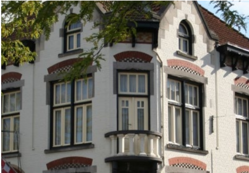
Figuur 7: Karakteristiek gebouw aan de buitenste schil
