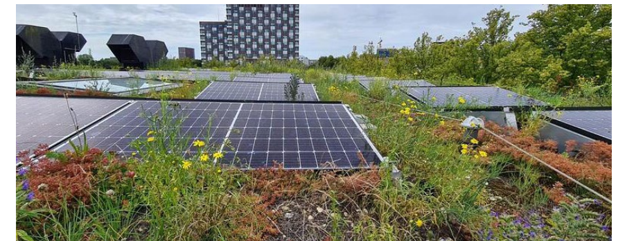
Figuur 64: Groendak (kruidendak) met zonnepanelen
