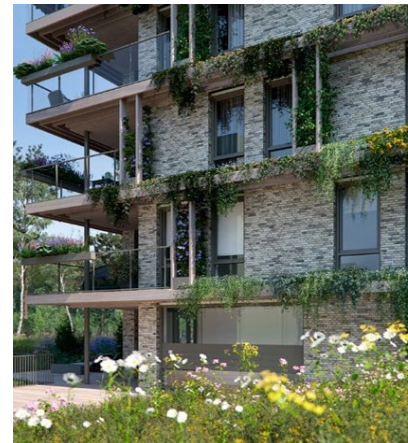
Figuur 18: Gevarieerd gebruik van baksteen icm groen
