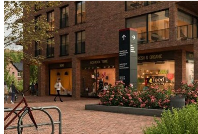
Figuur 35: Plint als onderscheidend onderdeel in de gevel
