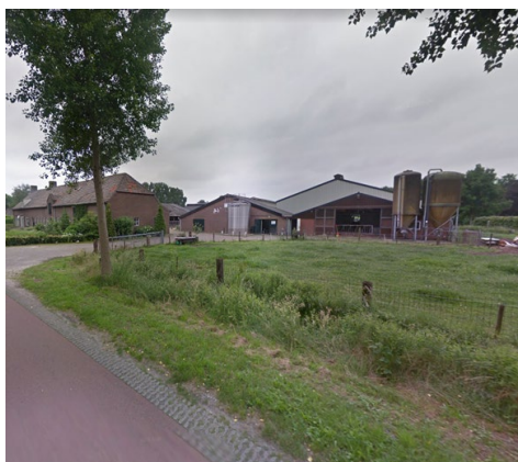
BEDRIJFSWONING AGRARISCH BEDRIJF PLEIN 21 MET BIJBEHORENDE STALLEN
