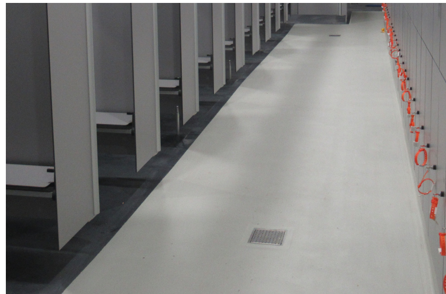
v4 troffelvloer inclusief holplint twee contrasterende mono-kleuren (schone/vuile voetengang) anti-slip uitgevoerd in de natte ruimtes
