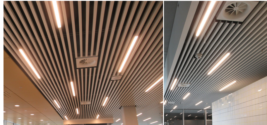
P4 wit aluminium strokenplafond uitneembaar, met daarop zwarte akoestisch dekens geïntegreerde lijn armaturen en technische elementen - alles in wit
