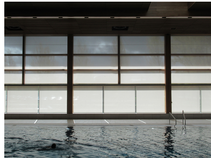
A2 binnenzonwering op zuid en oostgevel, translucente rolschermen
