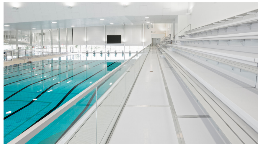
A5 ingeklemde glazen balustrade zonder balusters en zonder bovenregel bij tribune
