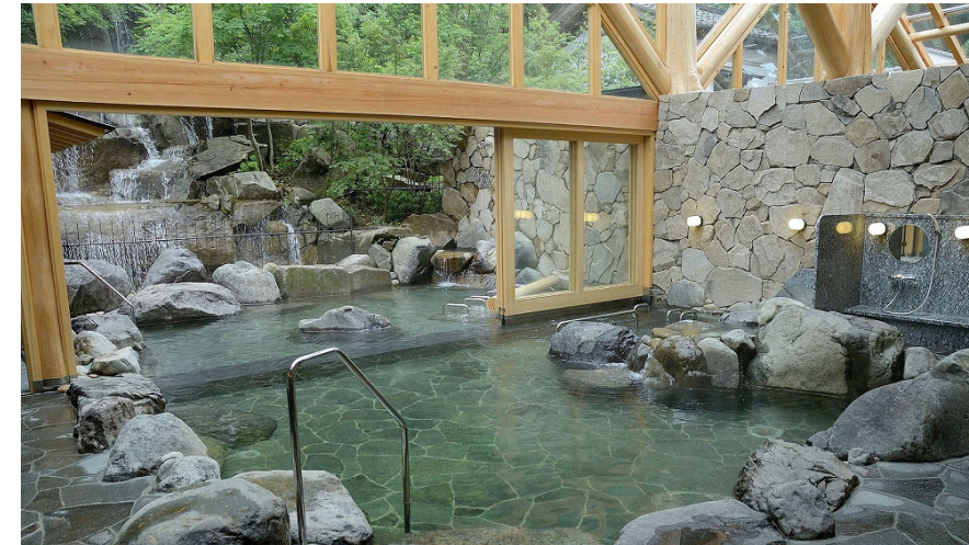
natuursteen elementen in vloeren en wanden, daarboven houten constructie
