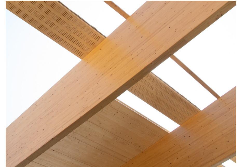
gelamineerd houten constructie, grenen
