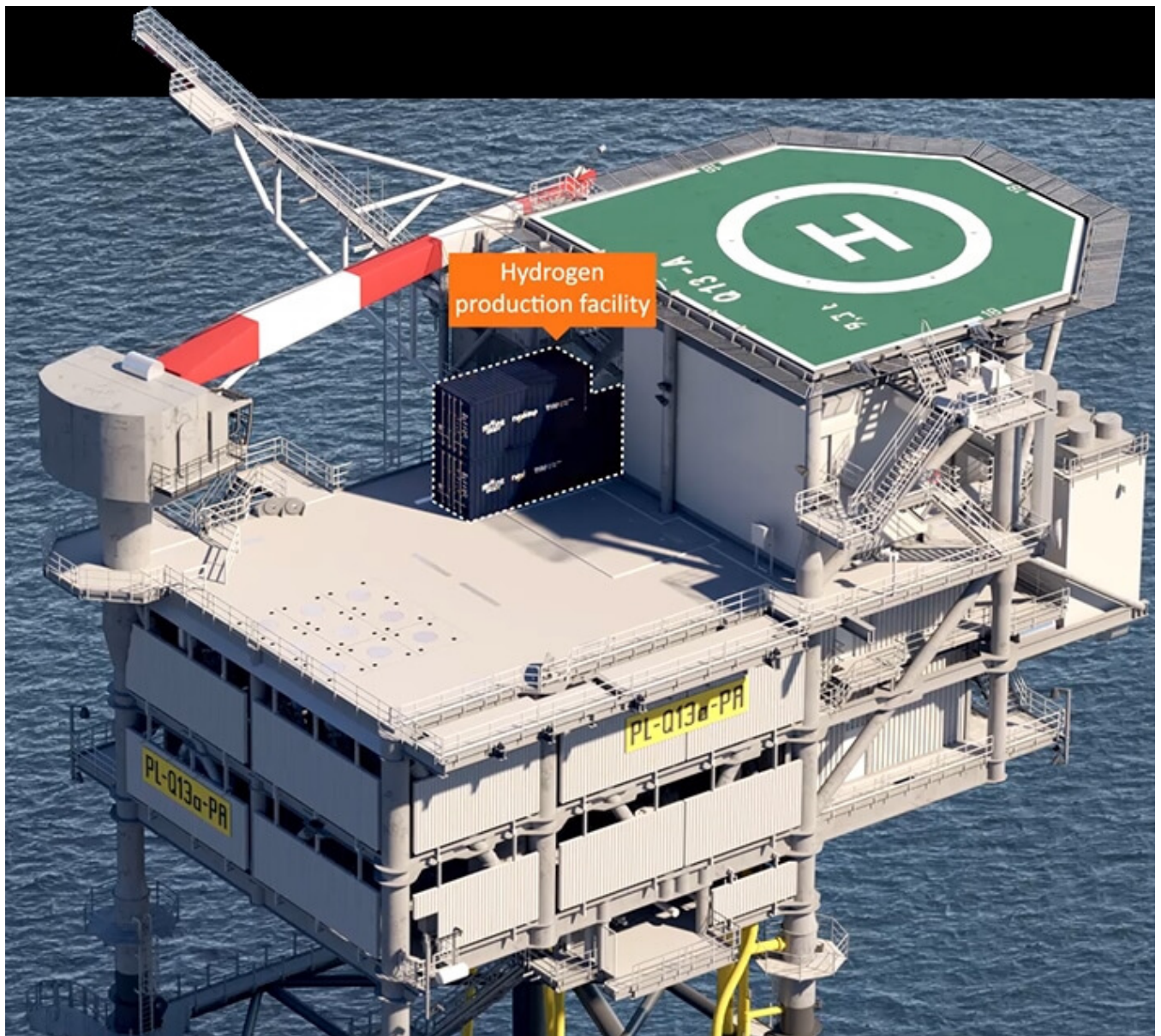
PosHYdon installatie: groene waterstof uit zeewater.
