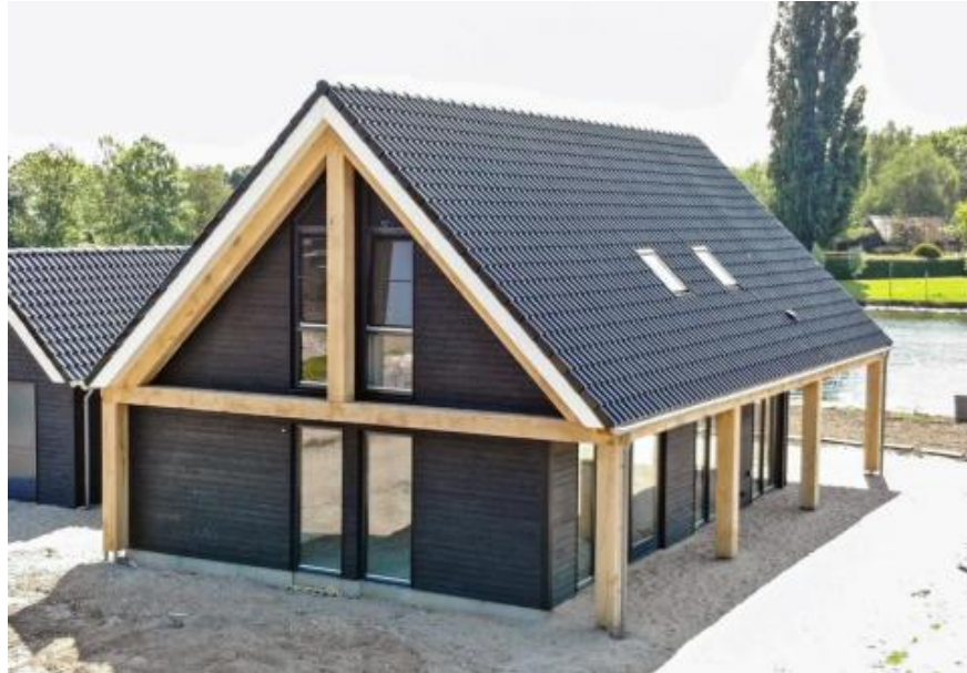
Voorbeeld van toepassing van naturel constructiehout in de gevel
