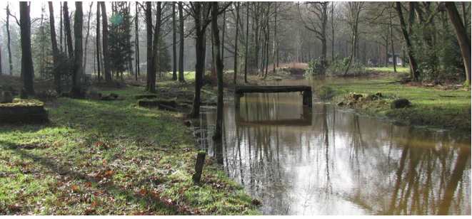
restanten van de oude brug zijn nog te zien.
