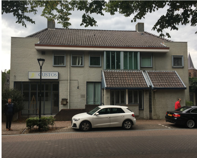
Voormalig bankgebouw sluit niet aan bij de gewenste beeldkwaliteit aan De Markt
