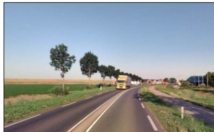
Figuur 3.3: De Domineesweg (bron afbeelding: CycloMedia)
