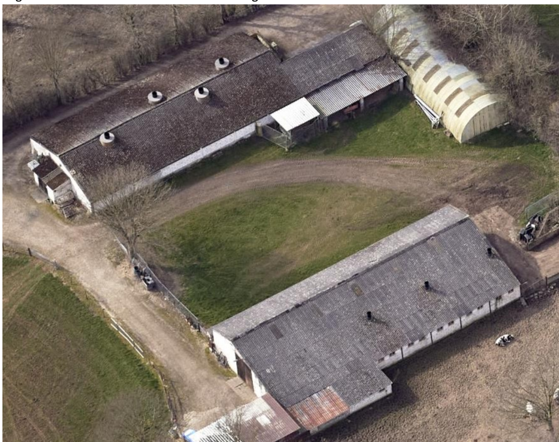
Figuur 3: asbesthoudende daken zonder dakgoot.
