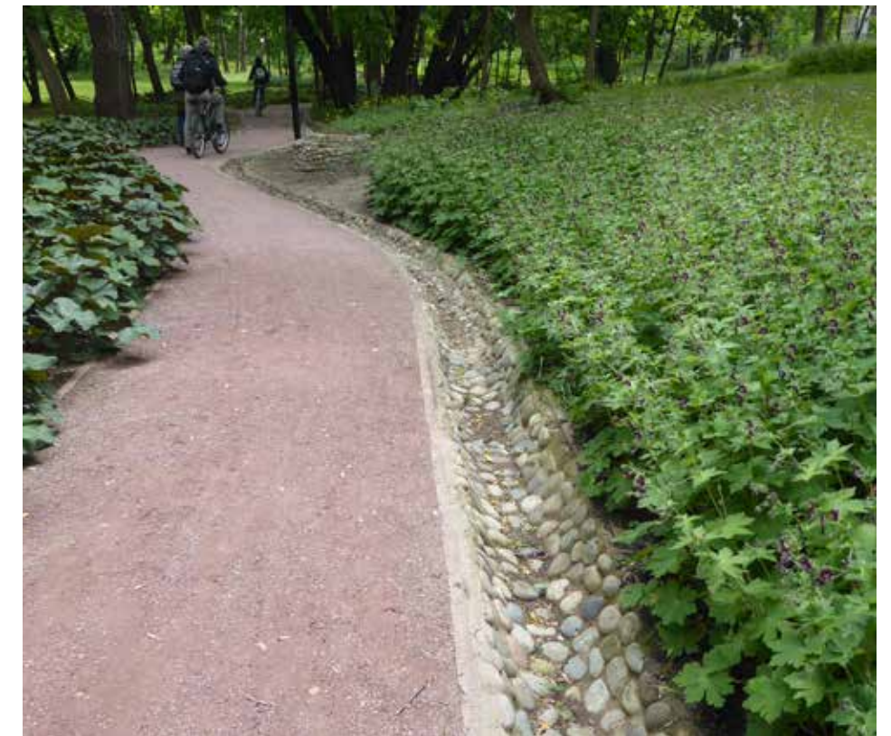
Voorbeeld parkpad met afwateringsgreppel
