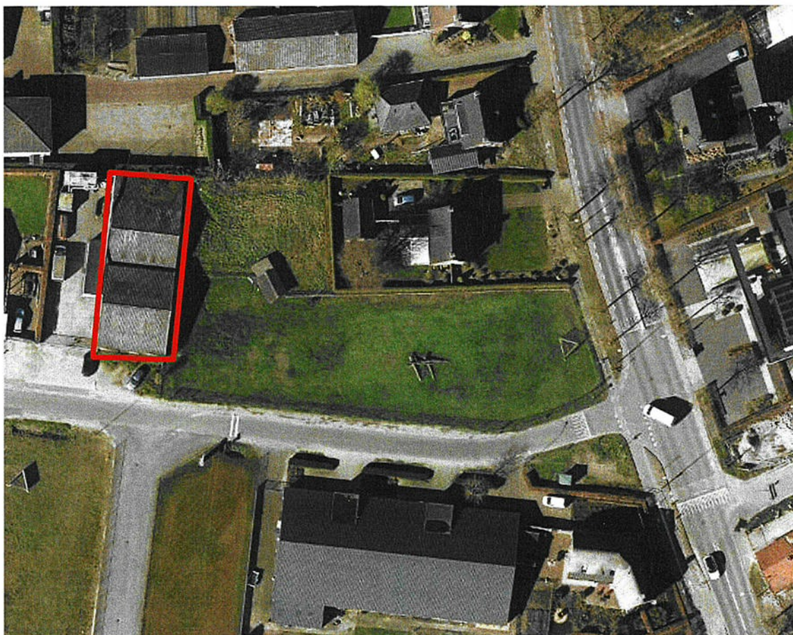
Figuur 2 te saneren gebouw omlijnd met rood
