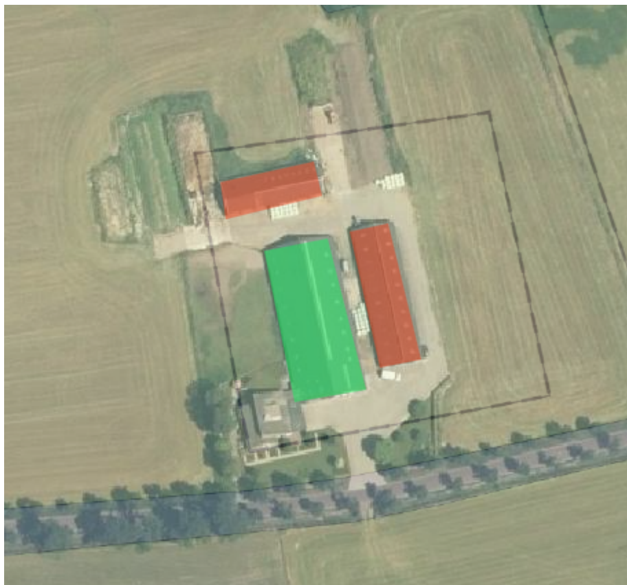
Figuur 2.2 te slopen gebouwen Hellendoornseweg 37
