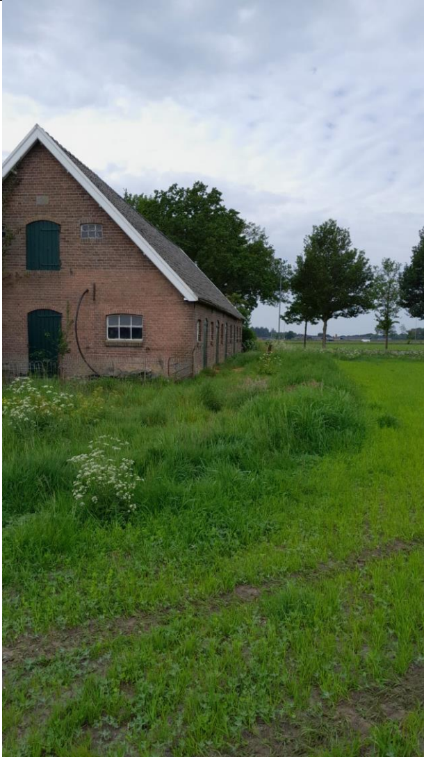
Locatie waar mogelijk ook nog puin in de bodem zit, achter noordelijke schuur Nijkerkerweg 128
