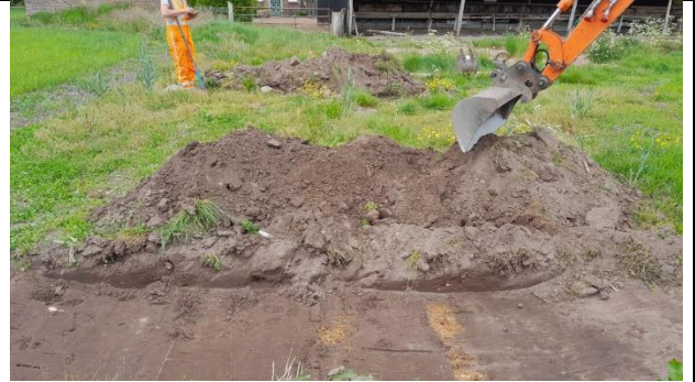
Puin achter oostelijke schuur Nijkerkerweg 128
