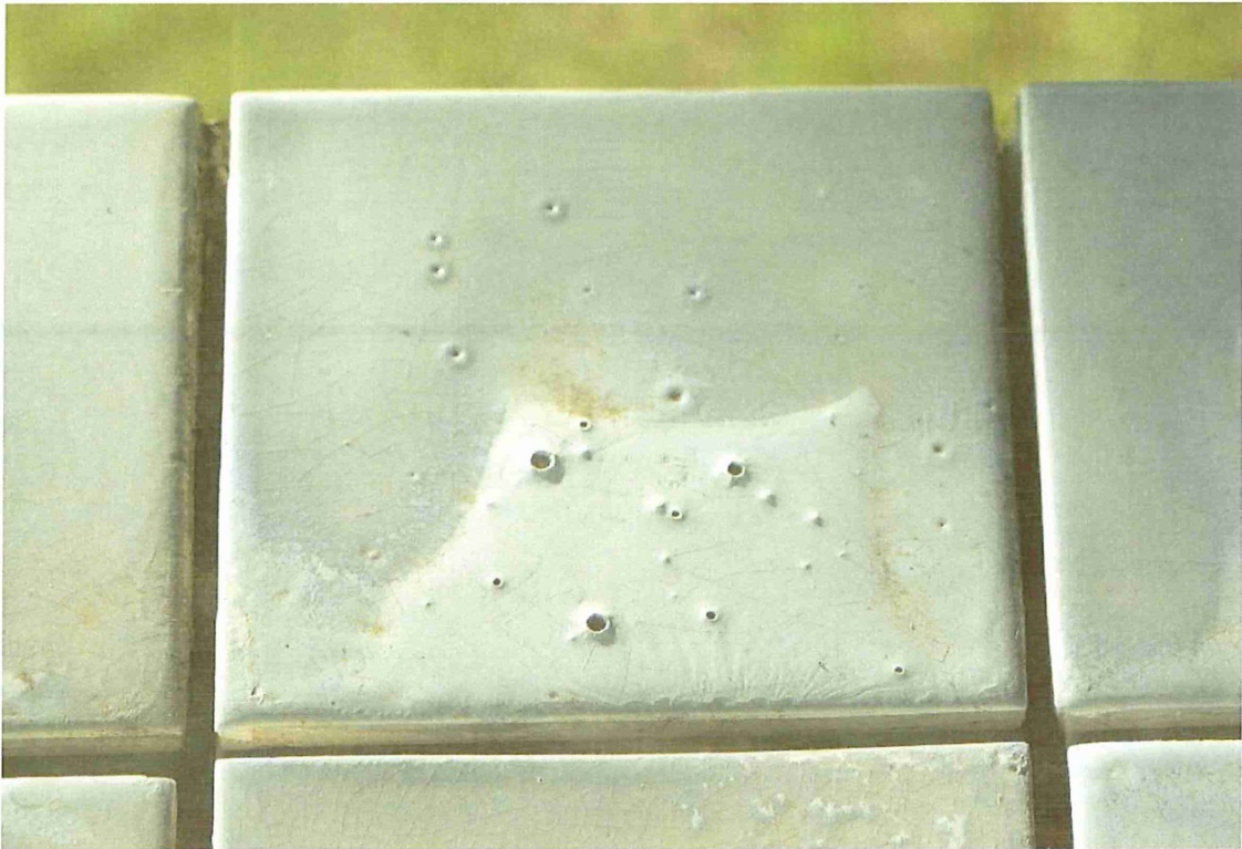
Foto 5: Kratervormige putjes in de glazuur. Ook zijn met name in de dunne, onderste glazuurlaag haarscheurtjes aanwezig.
