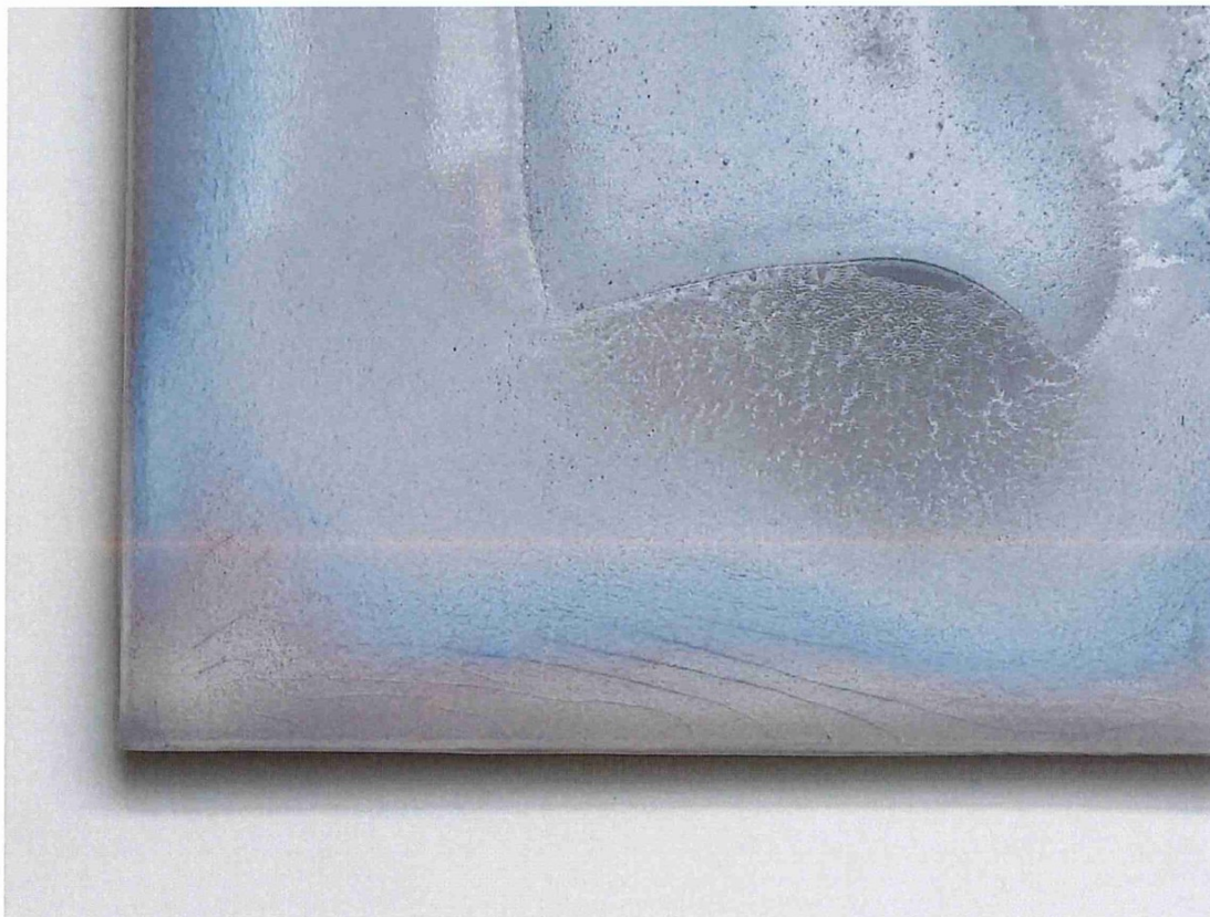
Foto 25: Rechthoekige haarscheuren ter plaatse van één zijde van een tegel na de vorstbestandheidstest. Bij de start van de test vertoonde deze tegel geen haarscheuren.
