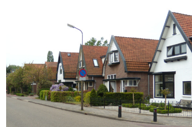
Bij gevarieerde spreiding kan de mate van beoordeling van bebouwing op zij- en achtererf per geval verschillen
