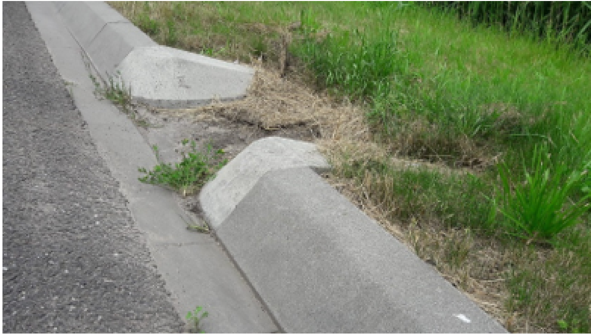
Voorbeeld oplossing waterpasserende trottoirband
