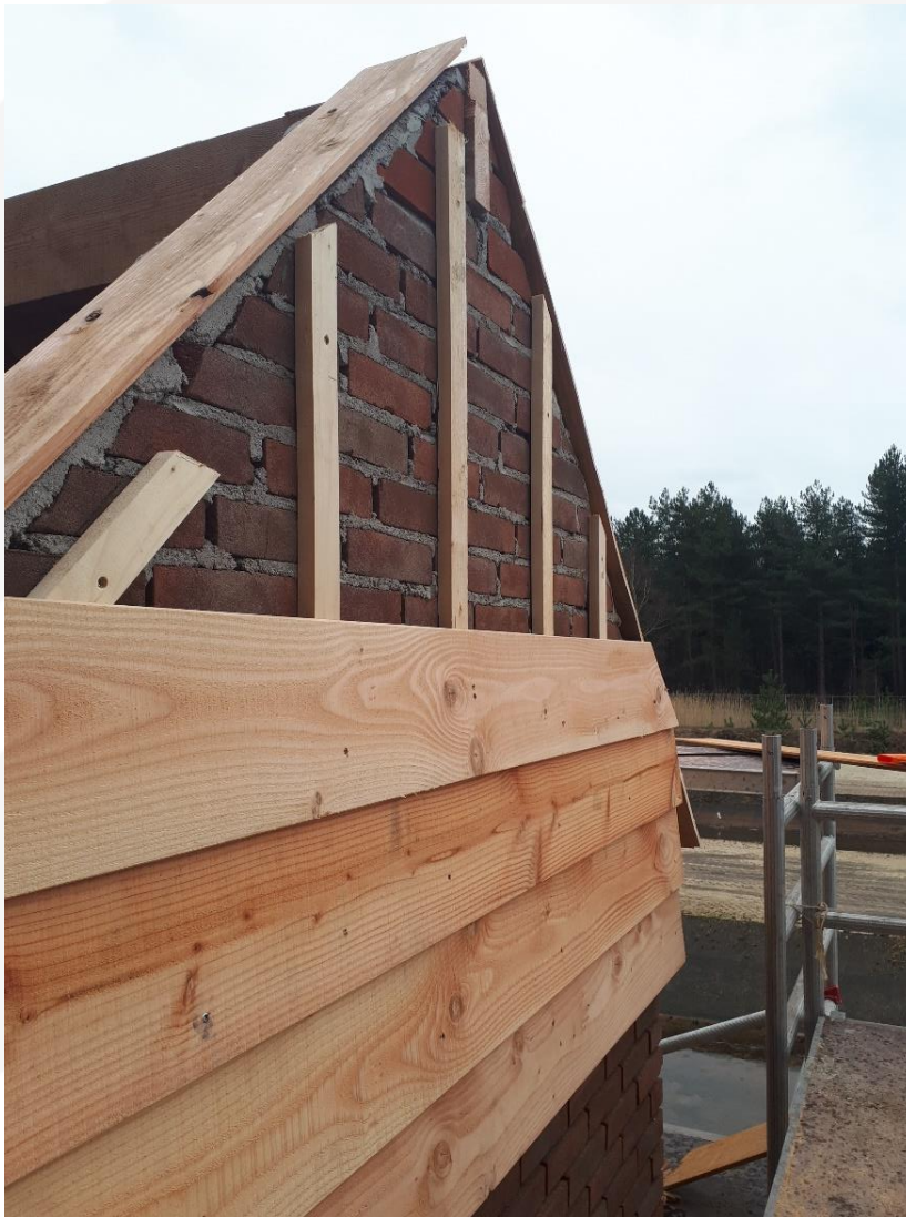
Figuur 13. Aanbrengen verblijfplaatsen vleermuizen middels gevelbekleding met planken.
