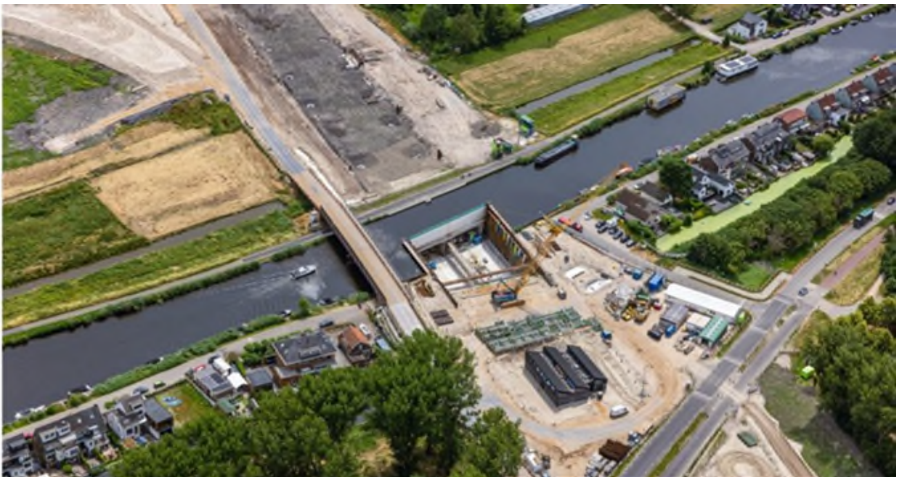
Aanleg tunnel onder de Rotte. Foto: Rijkswaterstaat
