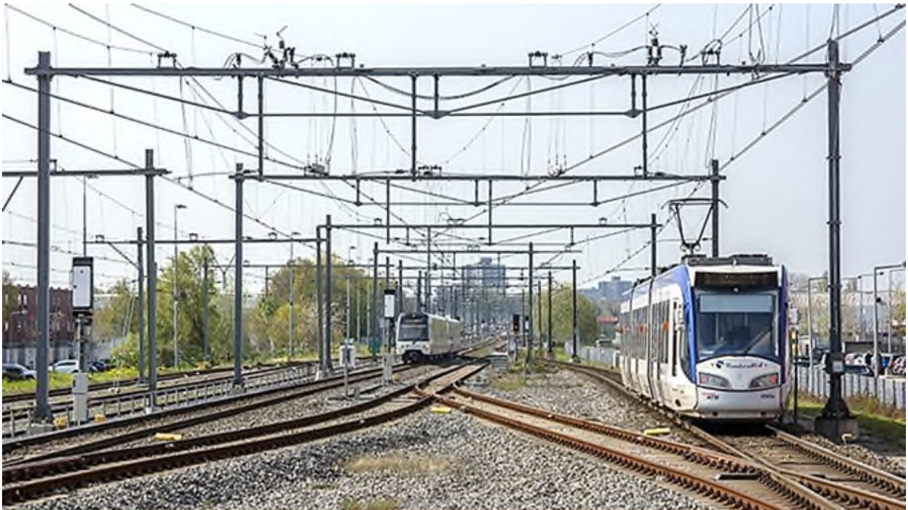
Metro- en RandstadRail-voertuigen op het samenloopdeel. https://hovm.nl/wp-content/uploads/2021/05/T201605-0071.jpg
