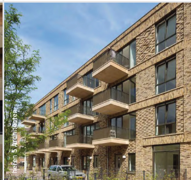
Horizontale accentuering in metselwerk met uitkragende balkons
