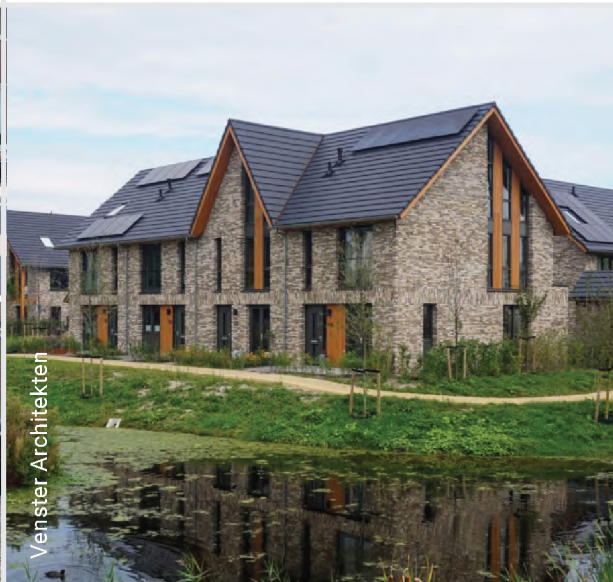
Eigentijdse uitstraling, horizontaliteit in metselwerk en verbijzondering kopgevel
