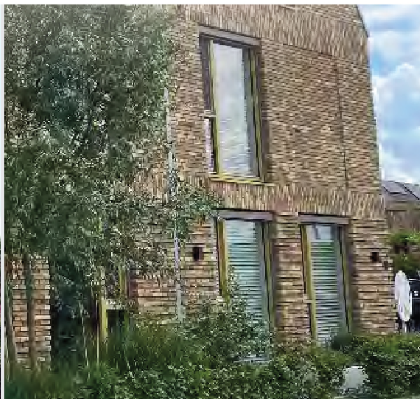
Metselwerkdetails ter verfijning van het volume
