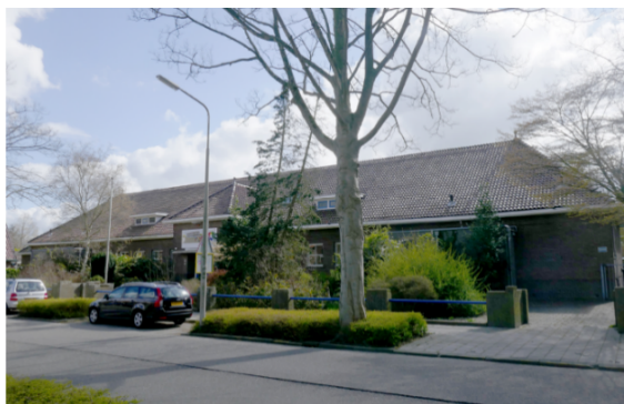
Hoofdgebouw voormalige basisschool
