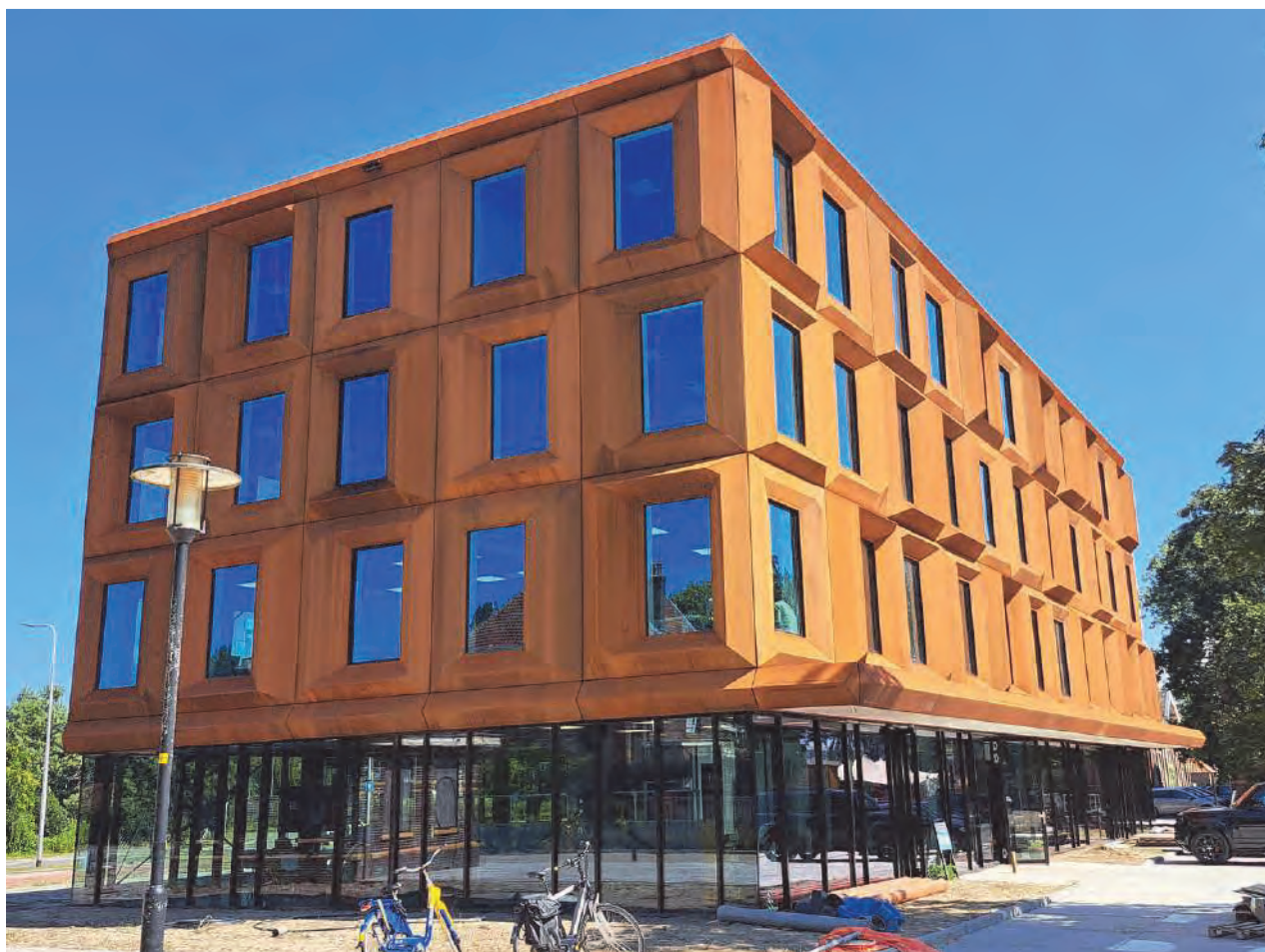
Zutphenseweg 6 (Gebouw X), Deventer
