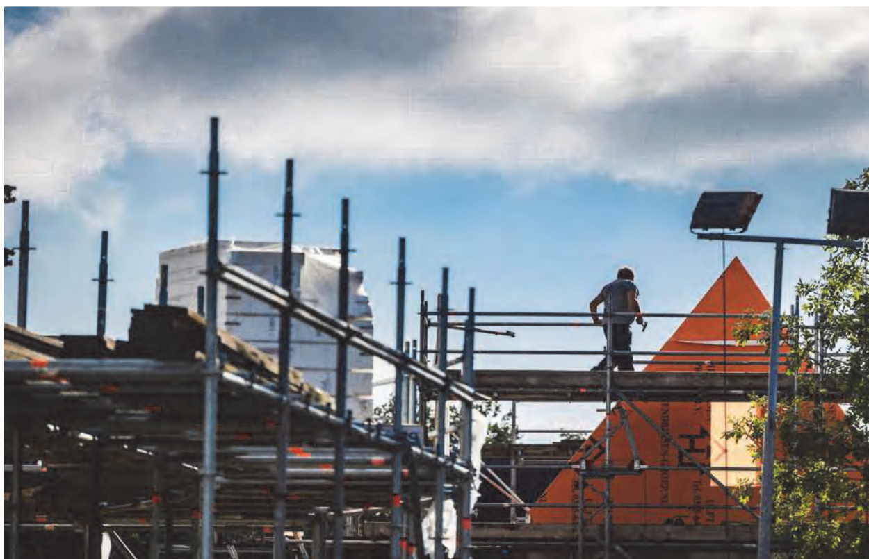
Woningbouw Helbergse Waard, Zutphen
