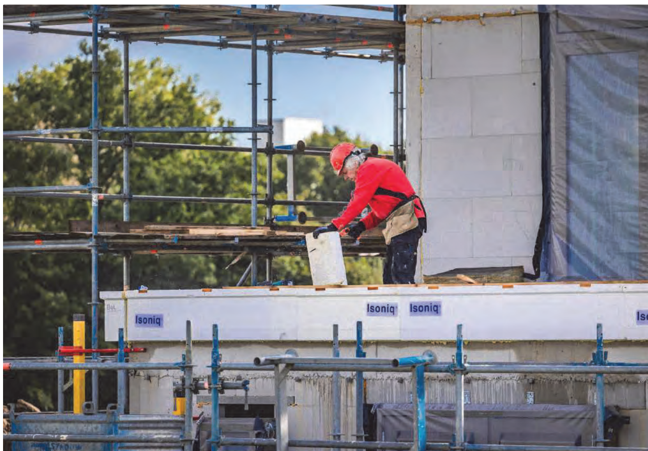
Woningbouw Helbergse Waard, Zutphen
