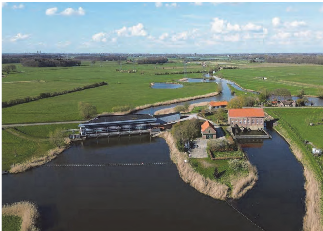
Gemaal in Werven, Heerde
