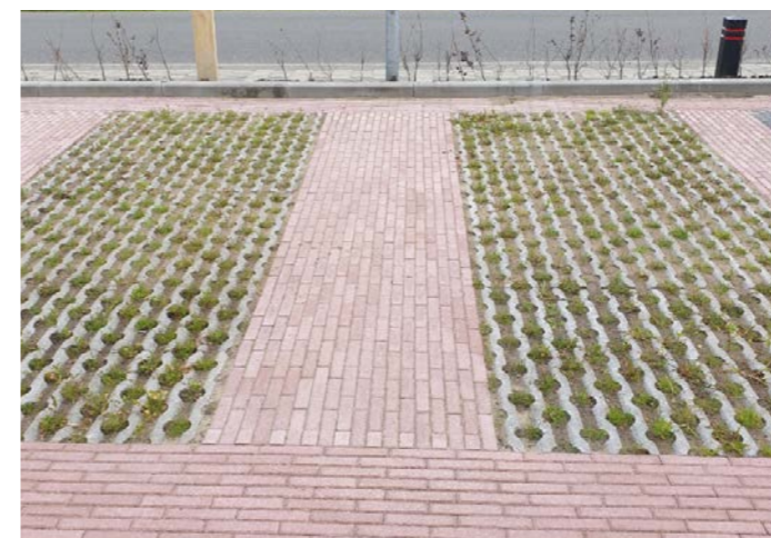
Parkeerplaatsen met halfverharding
