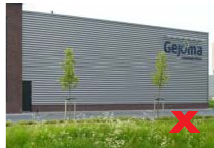
Geen dichte gevel aan Peelweg
