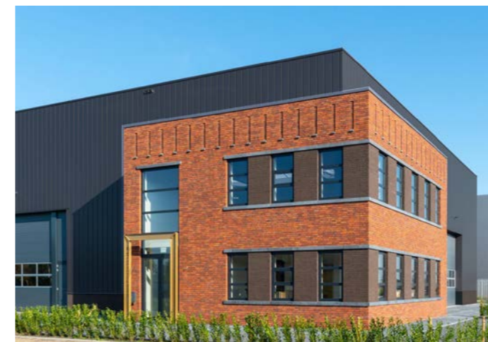
Materiaalgebruik baksteen in combinatie met plaatmateriaal
