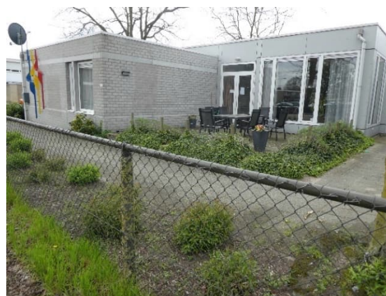
Afbeelding 3. Oostzijde van het onderzoeksgebied, ingericht met wandelpaden, een terras en gazonbeplanting.
