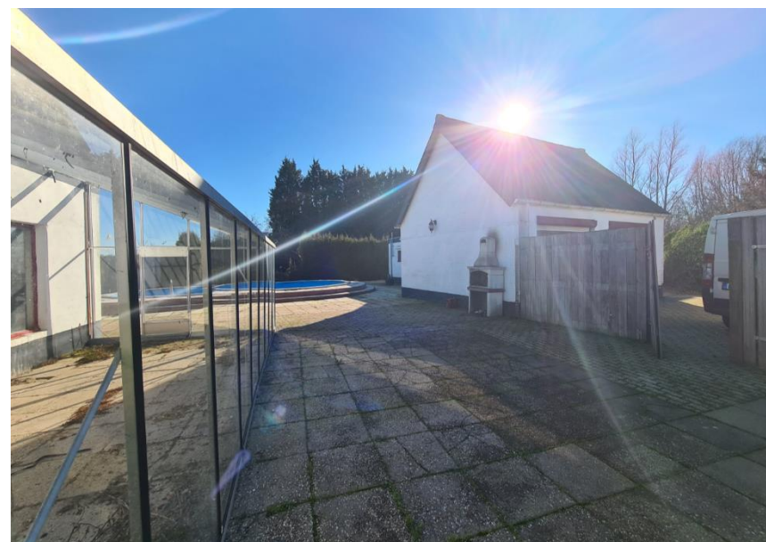
Figuur 6: Achterzijde bebouwing vanuit het noorden van het perceel
