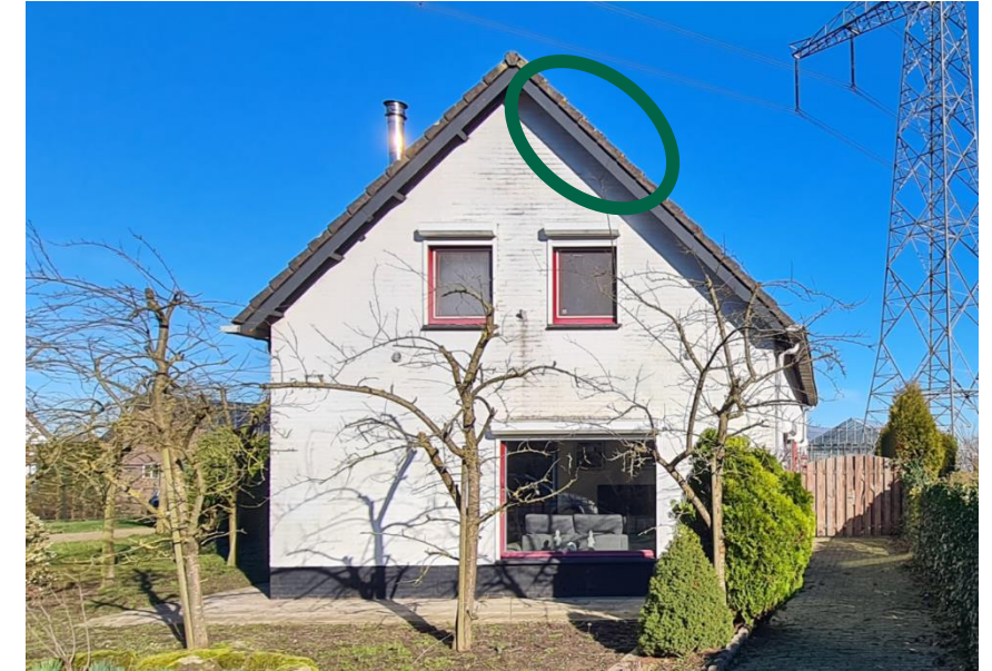
Figuur 8: Locatie zomerverblijfplaats gewone dwergvleermuis
