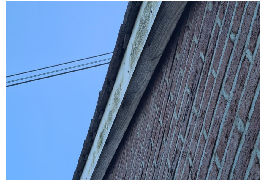
Figuur 12: Kieren tussen overstek en gevel
