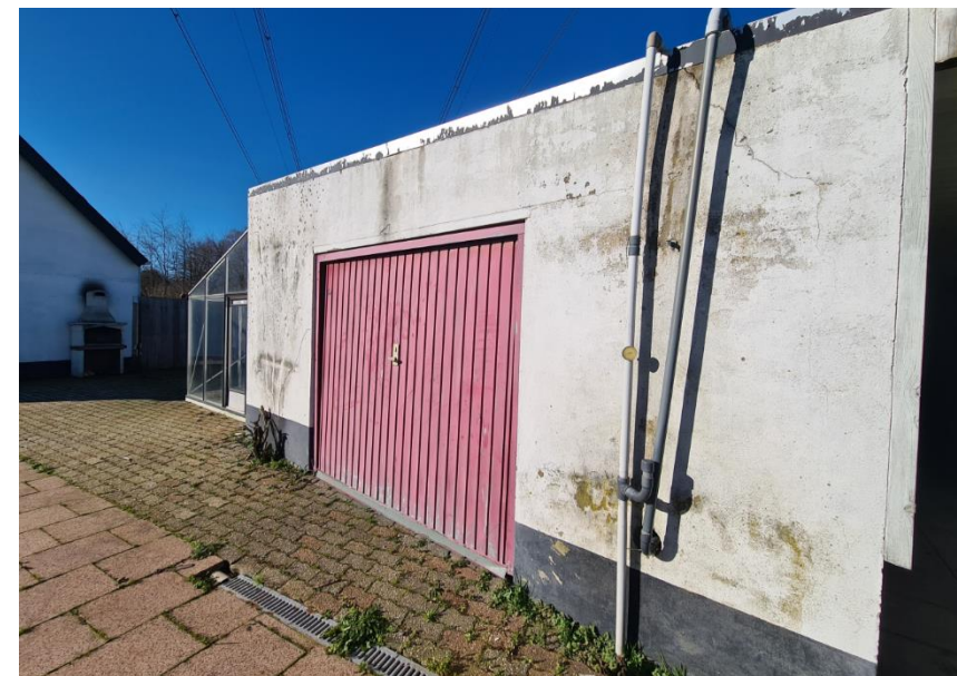
Figuur 4: Bijgebouw in de noordoostelijke hoek van het perceel
