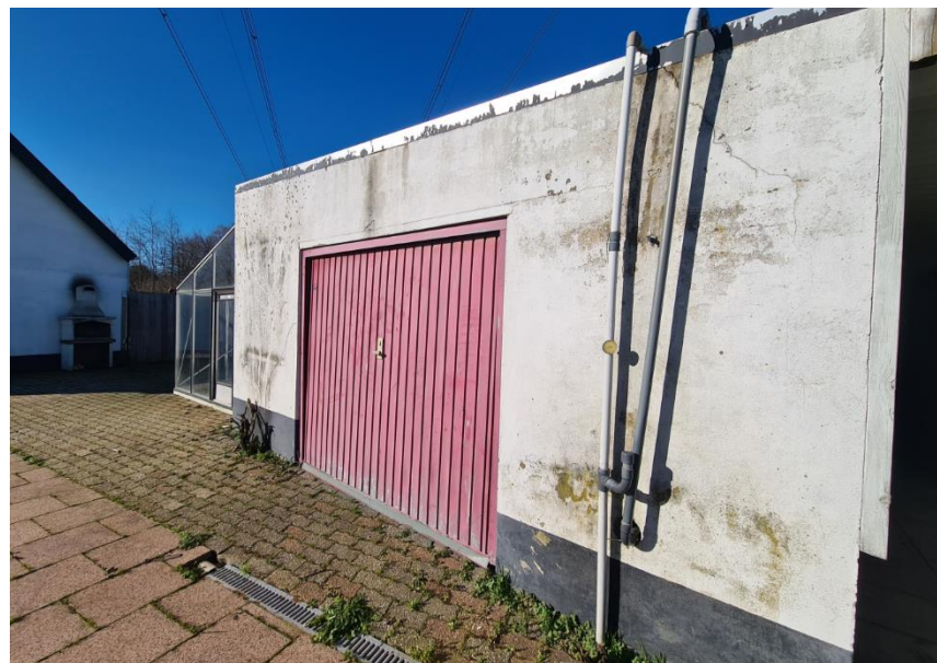
Figuur 7: Bijgebouw in de noordoostelijke hoek van het perceel
