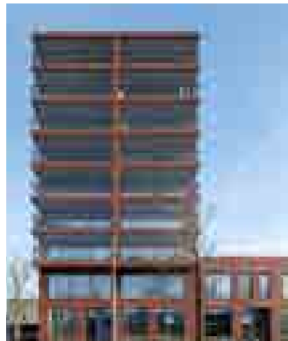
Rastergevel: reliëf in gevel en toepassing van terugliggend metselwerk in verschillende verbanden
