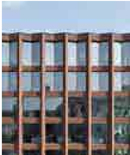
Rastergevel: reliëf in gevel en toepassing van terugliggend metselwerk in verschillende verbanden
