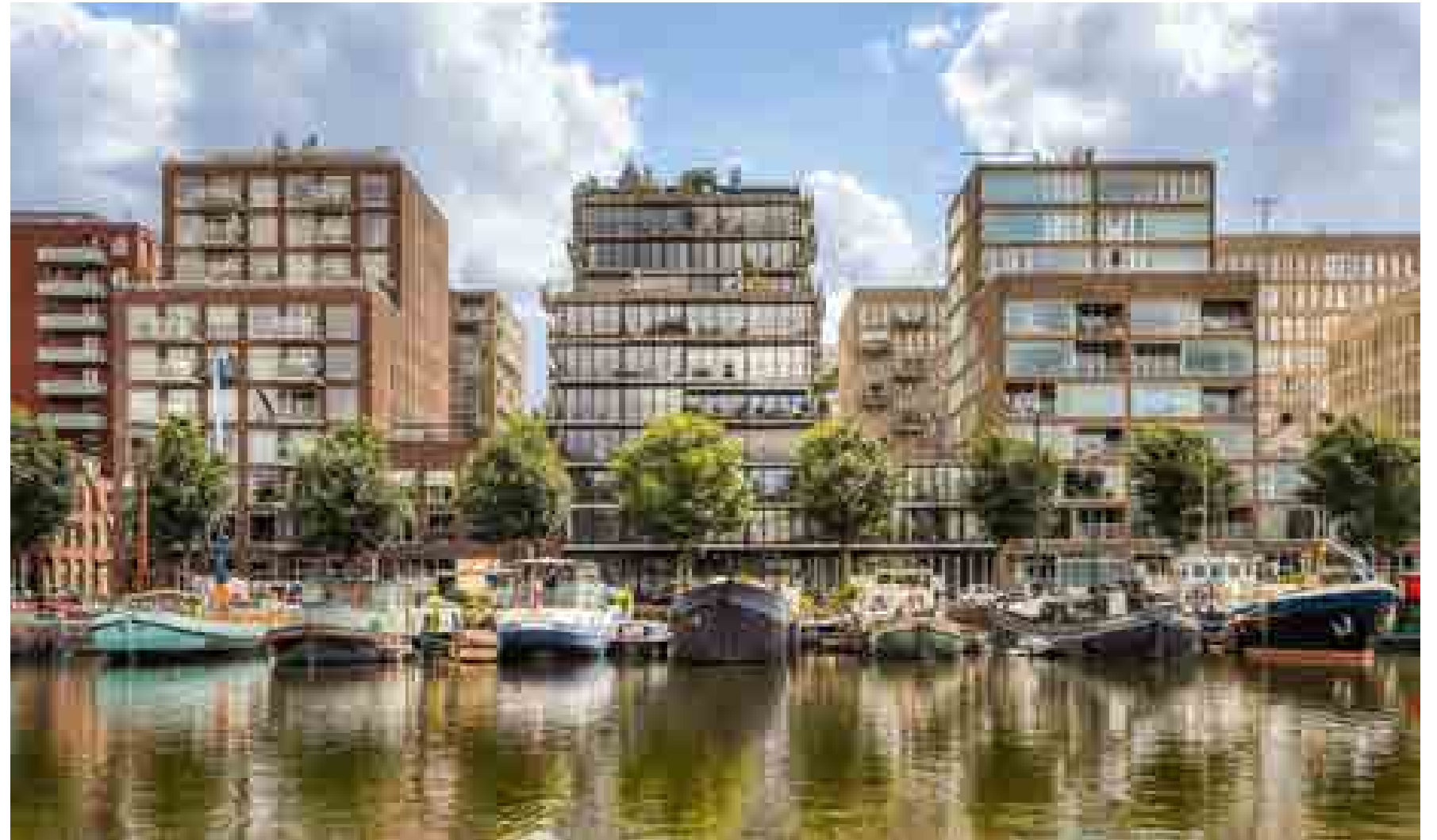
Hoog en laagbouw in één korrel, eenheid door toepassing van steenachtige materialen en veel glas, diversiteit door verschillende gevelopbouw - VOC Cour Westerdok, Amsterdam
