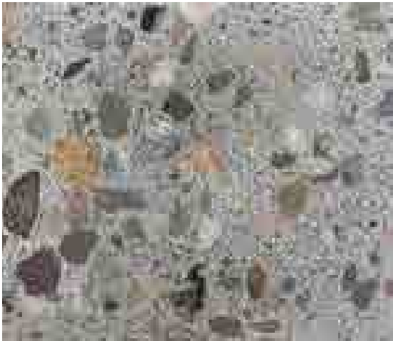
Betonnen tegelverharding met Maasgrind
