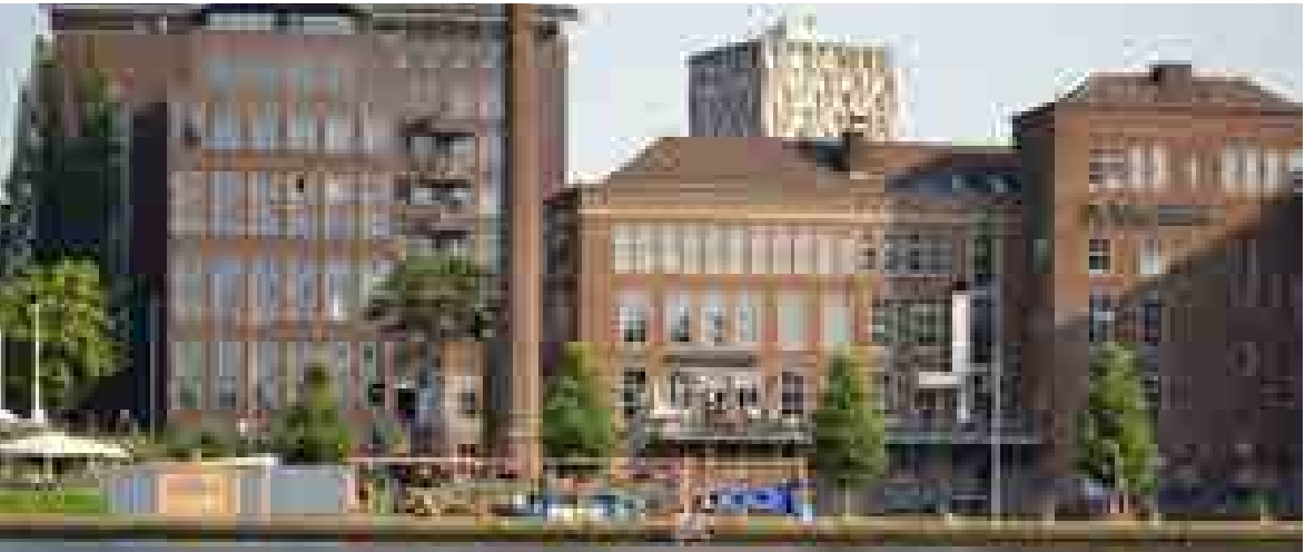
de Machinist en het Puntegaal gebouw
