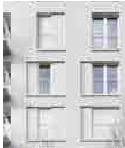
Rastergevel: reliëf in gevel en toepassing van terugliggend metselwerk in verschillende verbanden
