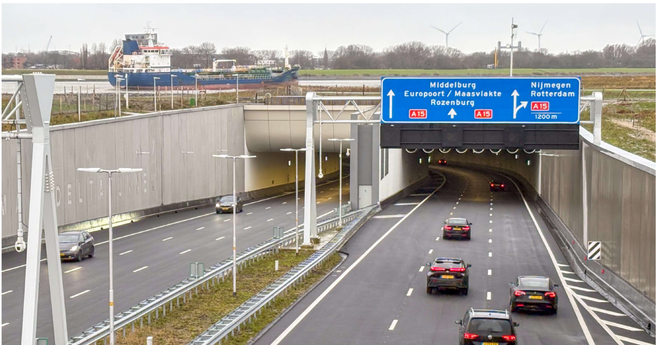
Maasdeltatunnel, gezien vanaf het noorden. Foto: Rijkswaterstaat
