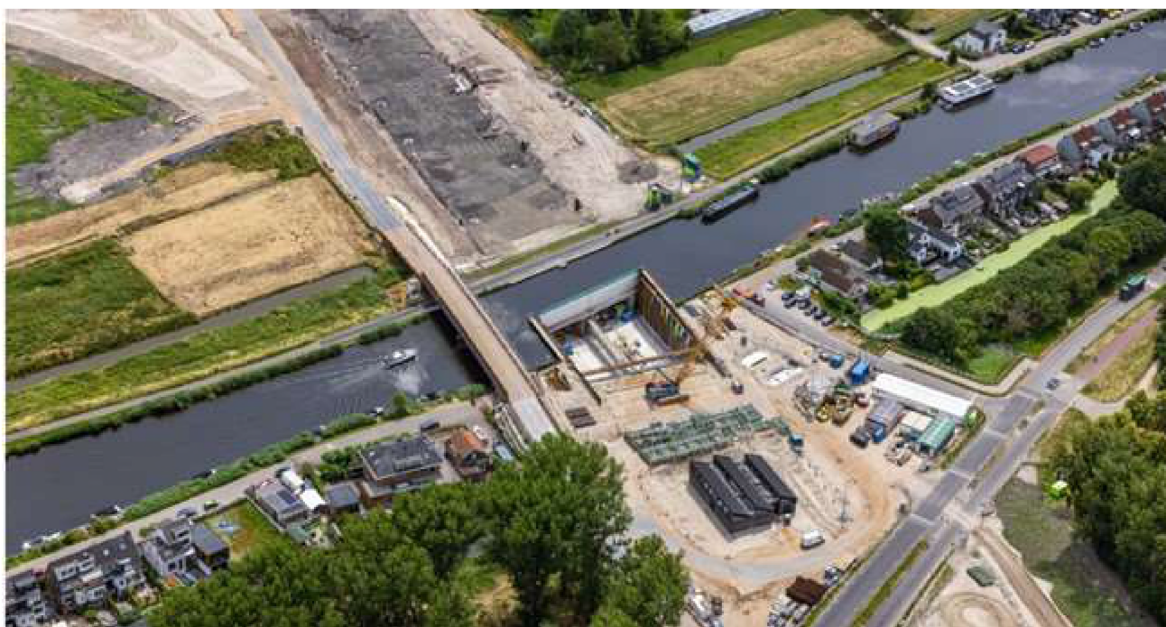
Aanleg tunnel onder de Rotte. Foto: Rijkswaterstaat
