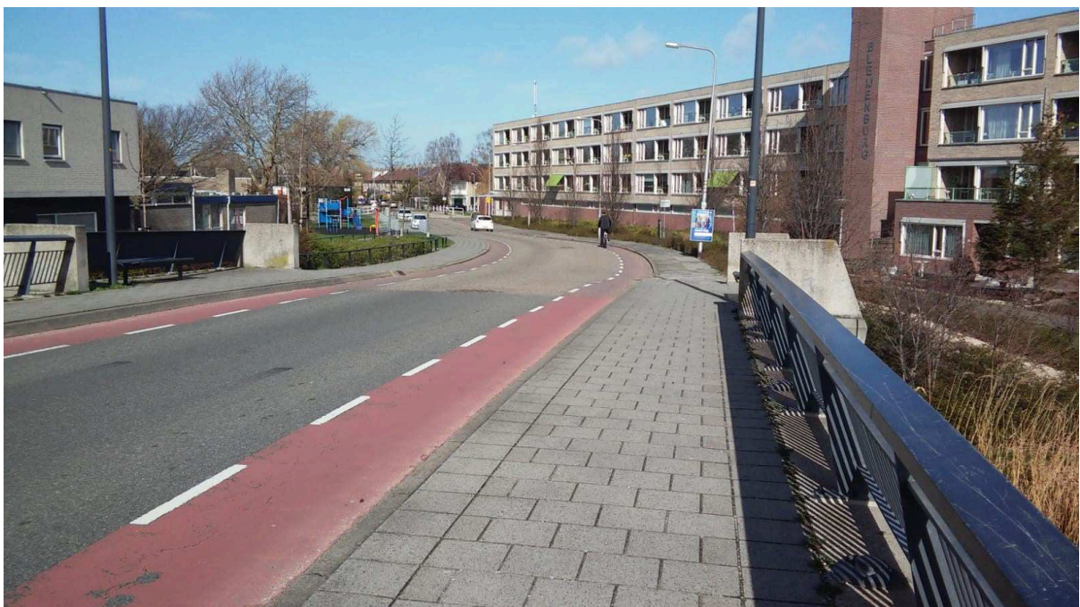
Foto 2: Deze foto is vanaf de Bleijenburg brug gemaakt in de verte ziet u het kruispunt. Doordat er een hoogte verschil is en de straat een lang stuk geen kruispunt tegen komt, gaat het verkeer te snel rijden.
