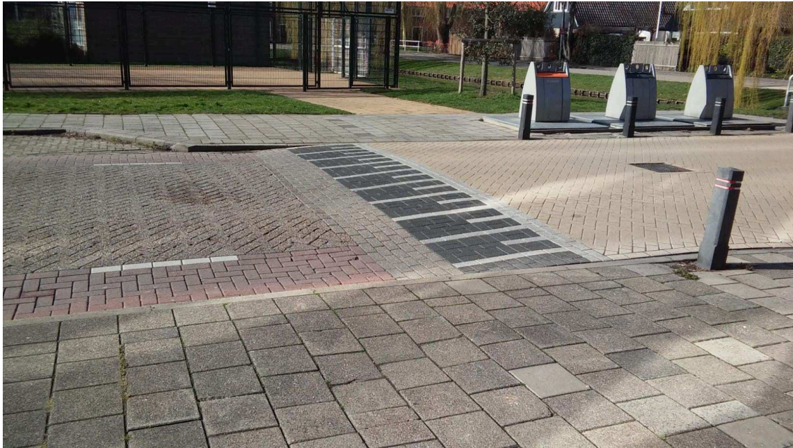
Foto 5: De jongerenraad adviseert om deze drempel een stuk naar links te verplaatsen en het zebrapad rechts van de drempel te plaatsen.
