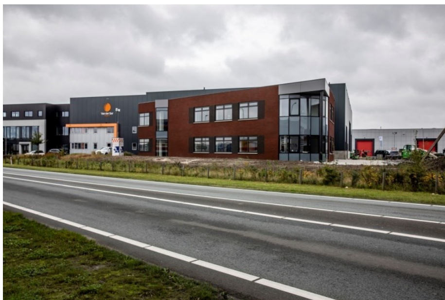
Nieuwbouw in Leehove
