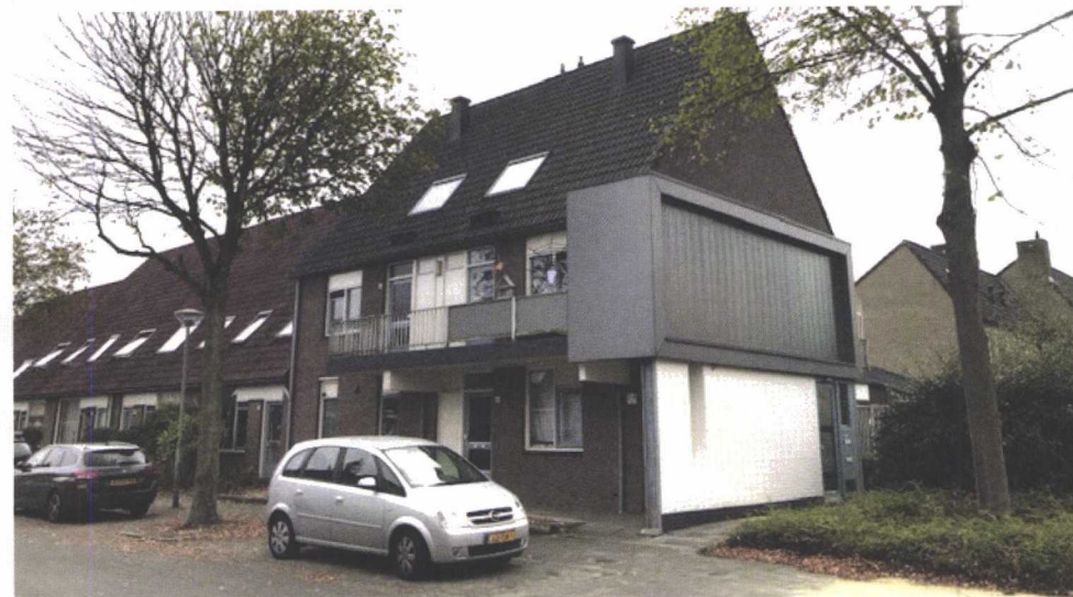
Project Heggeroosstraat, Blerick
