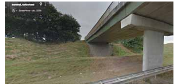
Viaduct over de A15 in De Plak (aan weerszijden verbreed of geheel vervangen) -> zelfde doorgangsprofiel en positie tussensteunpunten, architectonische vormgeving van de verbredingen conform eisen 'nieuw viaduct A15'
