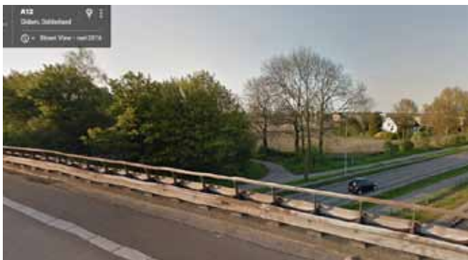
Viaduct over de Hengelderweg (Zevenaar) -> nieuw viaduct
