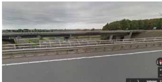
Nieuw viaduct in de A15 over de Bouwlustlaan / spoorlijn Arnhem-Nijmegen -> zelfde doorgangprofiel en positie tussensteunpunten, nauw verwante architectonische vormgeving
