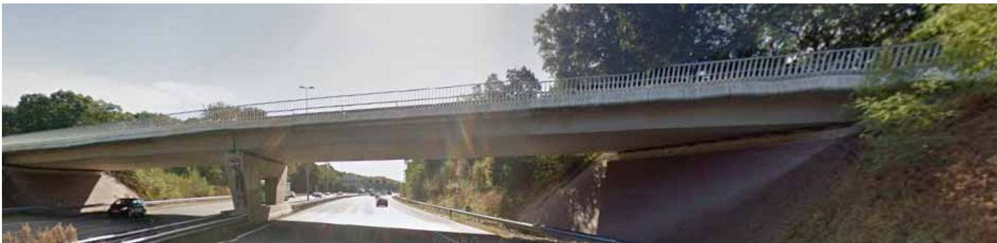
Referentie: viaduct over de A12 in de Schelmseweg (bron: google)
