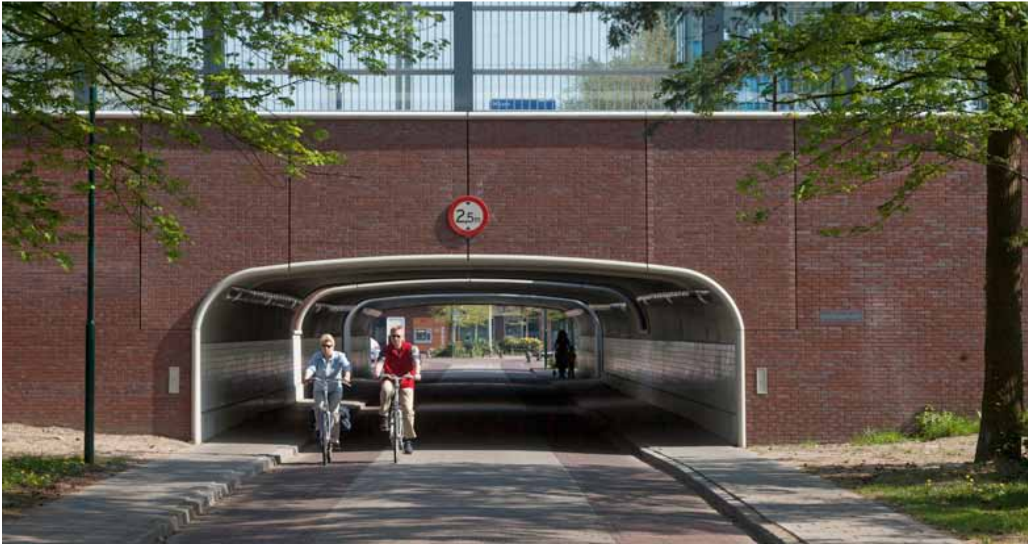
Verlengde onderdoorgang in de A12 in Maarn (bron: qwa.nl)
