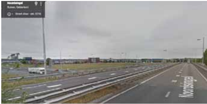
Viaduct in de Noordsingel / N810 (Duiven) -> geen bijzonderheden
