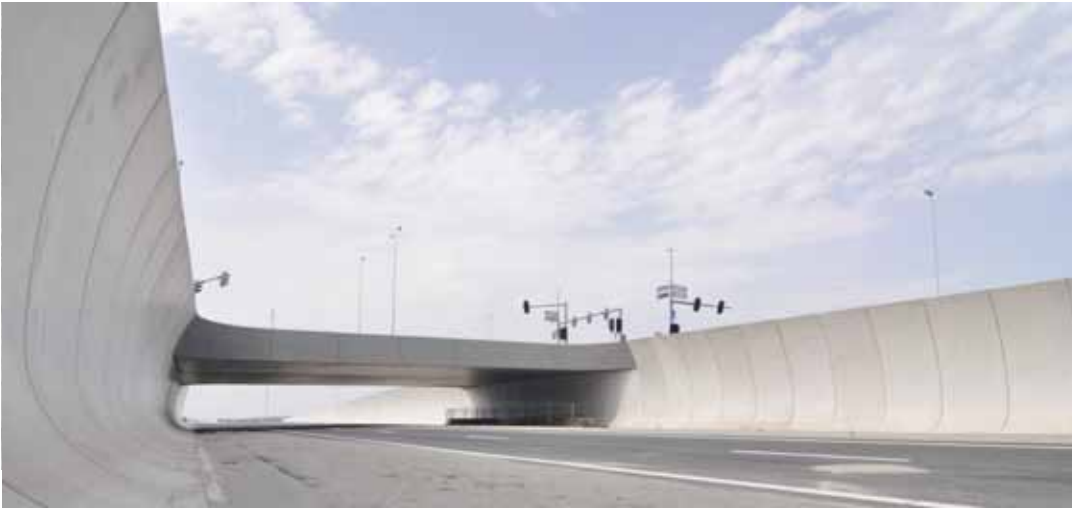
Voorbeeld van gebogen betonnen wanden in de N15 op de Maasvlakte (bron: zja.nl)
