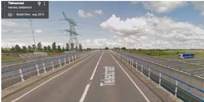
Viaduct over de A15 in de Tielsestraat (N836) -> aanpassing kleur leuningen, verwijderen gaasramen (indien mogelijk)
