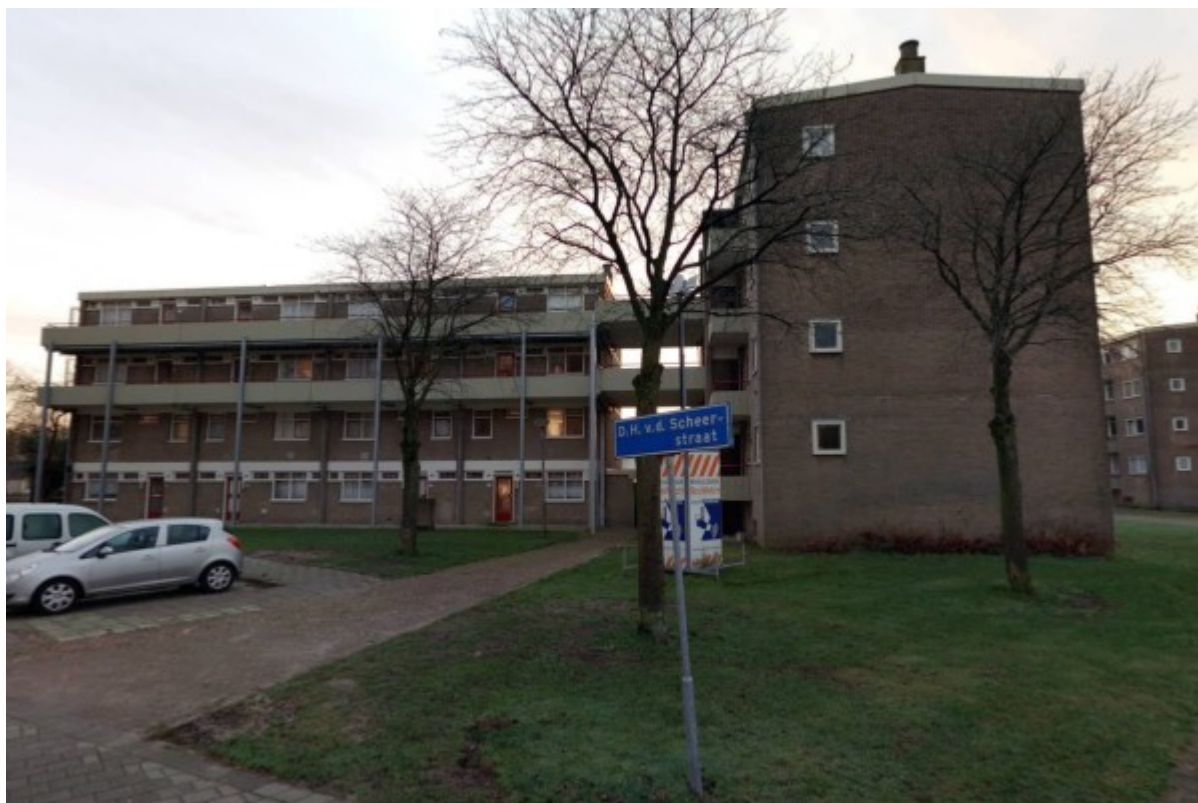
Foto 1.1: Beeld van de voormalige flats.
