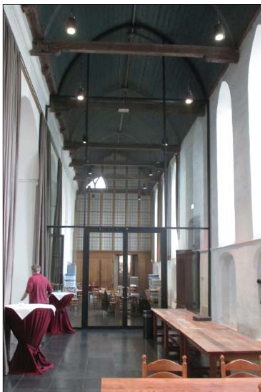
Foto: Interieur Geertekerk met nieuwe glazen pui uit 2016 voor multi- functioneel gebruik.
