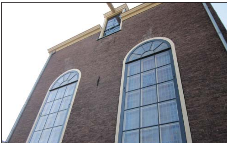
Foto: Doopsgezinde kerk achtergevel van de kerk- zaal met voorzetramen aan de buitenzijde.
