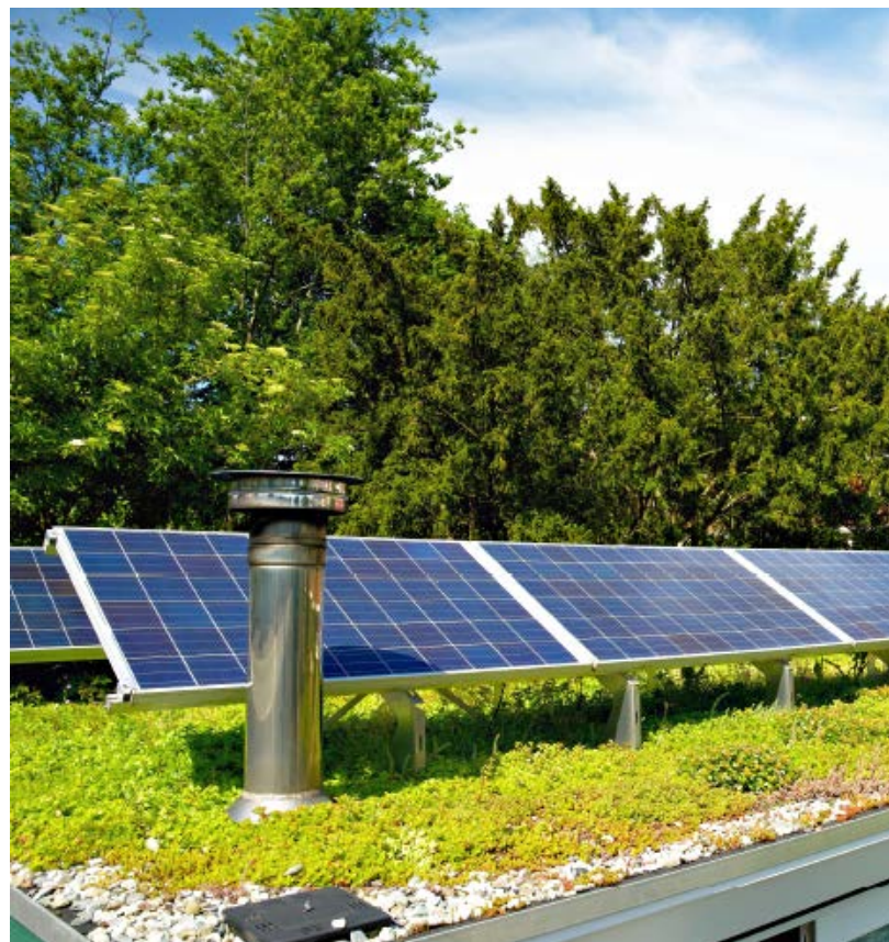
Groen dak en combi groen met zonnepanelen. Bron: Arcadis
