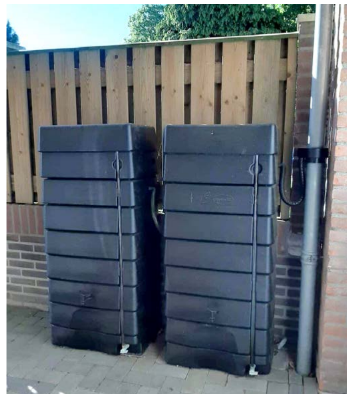
Afgekoppelde regenpijp met afvoersteen en regentonnen. Bron: GWWtotaal (links), Voertonnen.nl (rechts)
