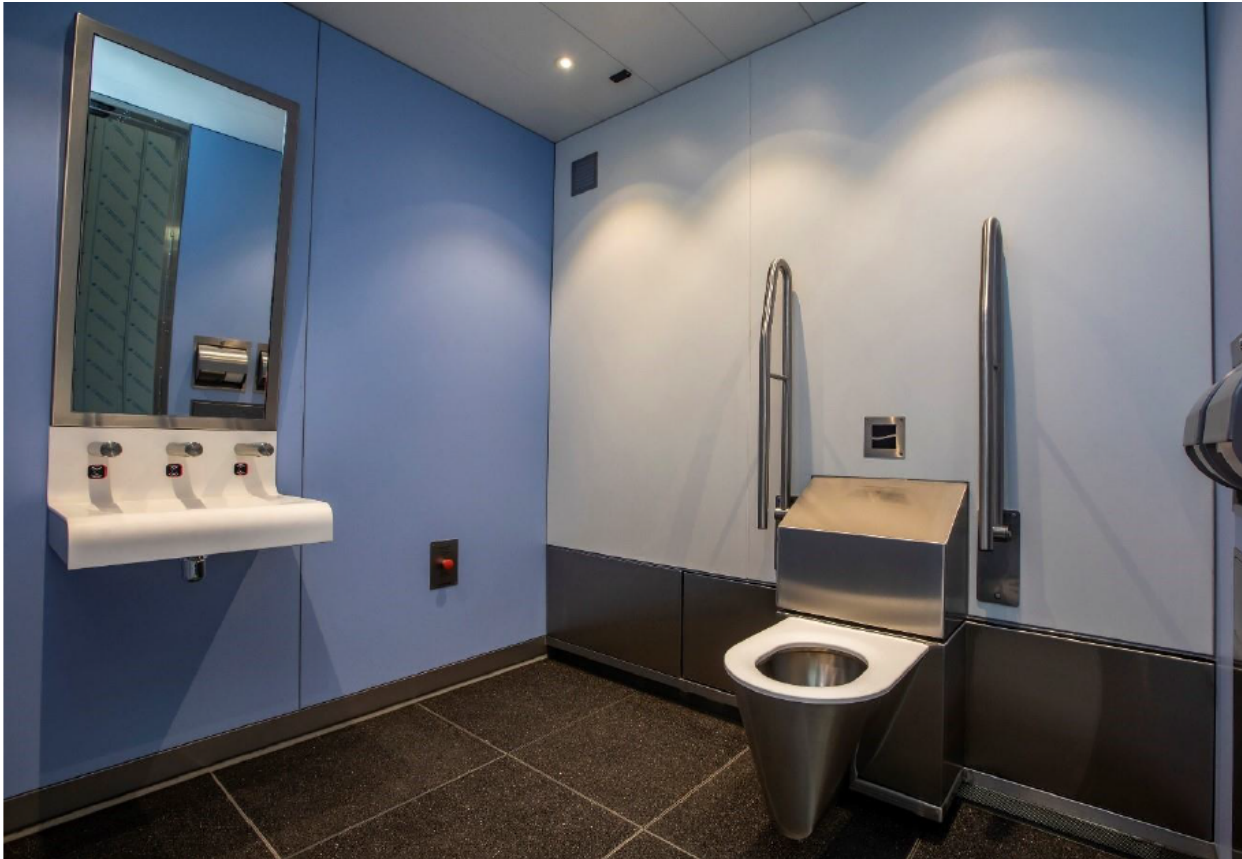
Foto: Inrichting van een zelfreinigend mindervalide toilet
