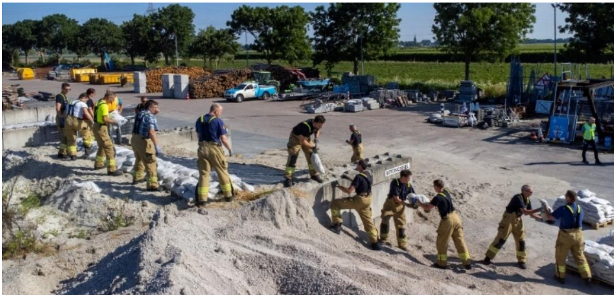
Eén van de zeven praktijktesten bestond uit de inzet van de brandweer voor het versterken van een (verzwakte) dijk.
