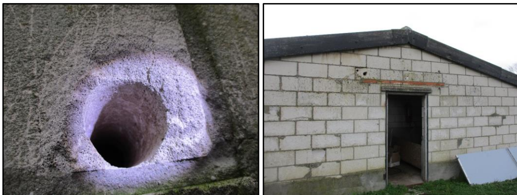
Figuur 6a Openingen en muurbreedtes waaruit blijkt dat de gevel geen spouw heeft
