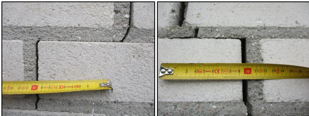
Figuur 4 Scheuren zijn te smal voor vleermuizen om in te kruipen
