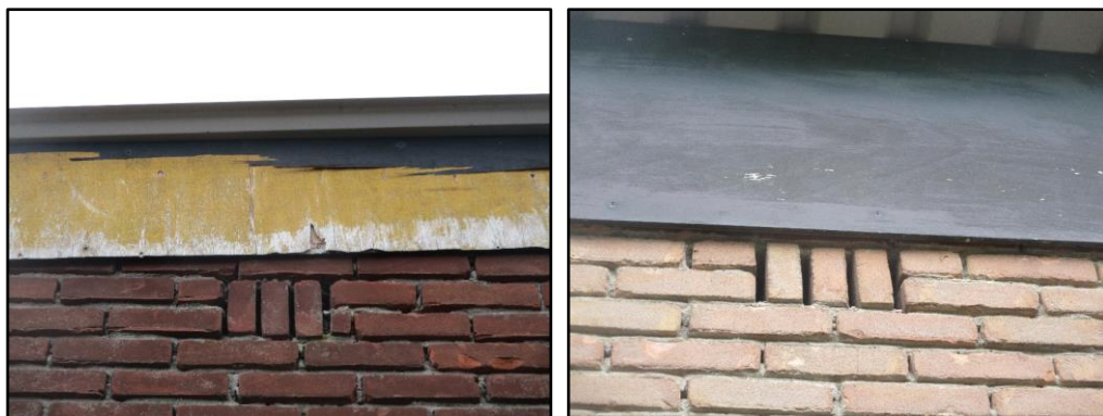
Figuur 9 Het transformatiehuisje is geschikt als verblijfplaats voor gebouwbewonende soorten.
