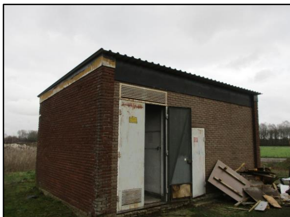
Figuur 1a Het transformatorhuisje.
