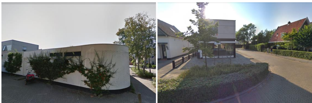
Impressie bebouwing aan de Westerweg 279. Linker afbeelding toont de aanbouw, rechter afbeelding toont het hoofdgebouw (bron: Google Streetview)
